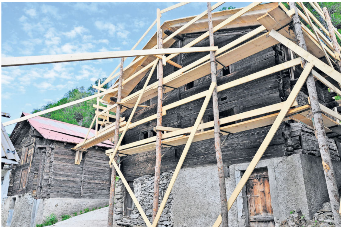
Eingerüstet. Das Haus in der Unteren Warbfluh unterhalb von Mund ist gesichert: Hauptteile stammen aus dem Jahr 1435.
