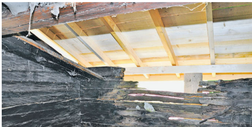
Schäden. Löcher klaffen in der Wand, nun geschützt durchs provisorische Dach. Abgetragene Steinplatten stapeln sich auf der Wiese.
